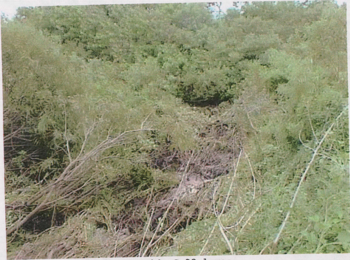
S. side C-23 levee
